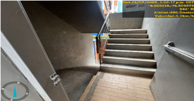
Escalera común - CJ
