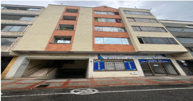
Fachada del Inmueble
