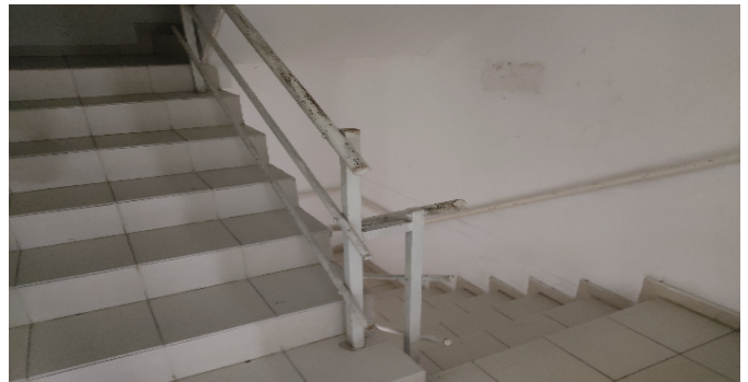
Escalera común - CJ
