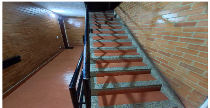
Escalera común - CJ
