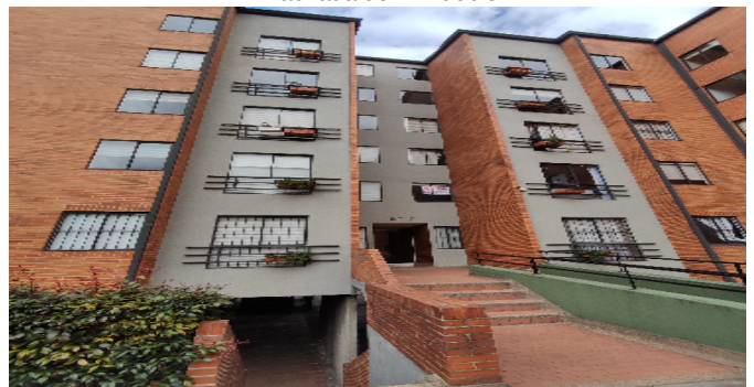
Fachada del Inmueble
