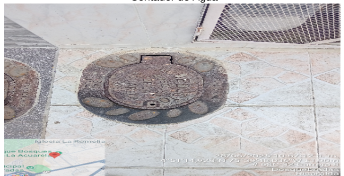
Contador de Agua
