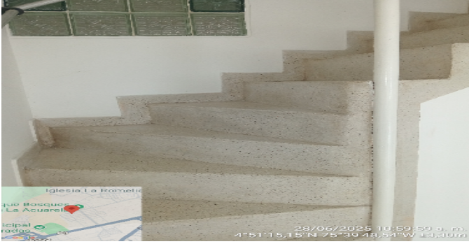
Escalera del inmueble
