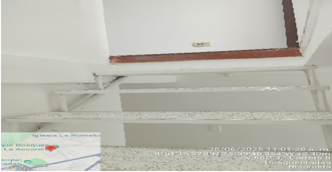
Escalera del inmueble
