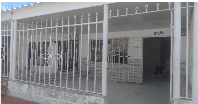
Fachada del Inmueble
