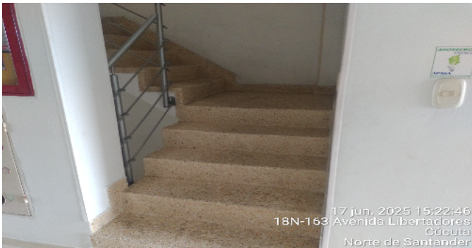
Escalera común - CJ
