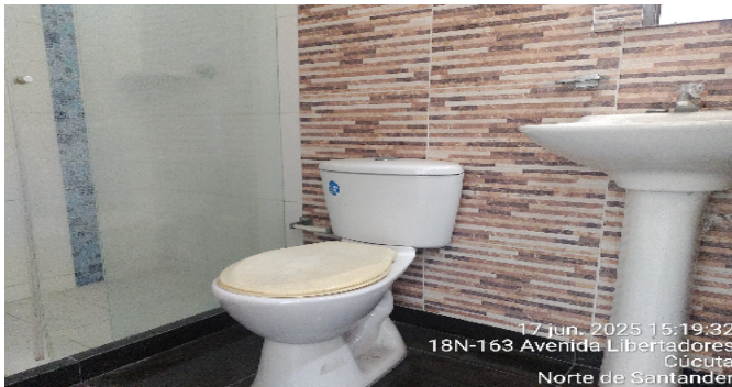
Baño Privado Hab 1
