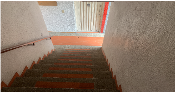
Escalera común - CJ
