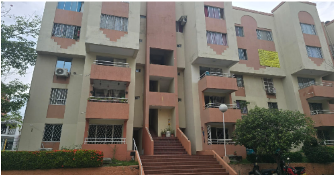
Fachada del Inmueble
