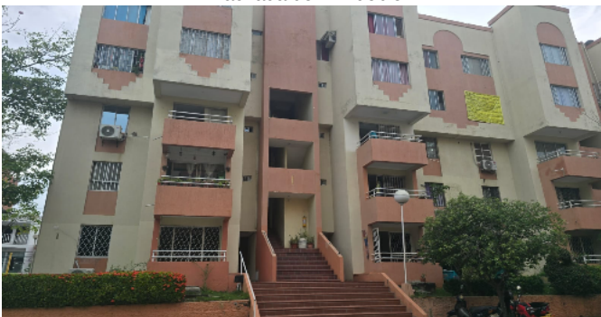
Fachada del Inmueble
