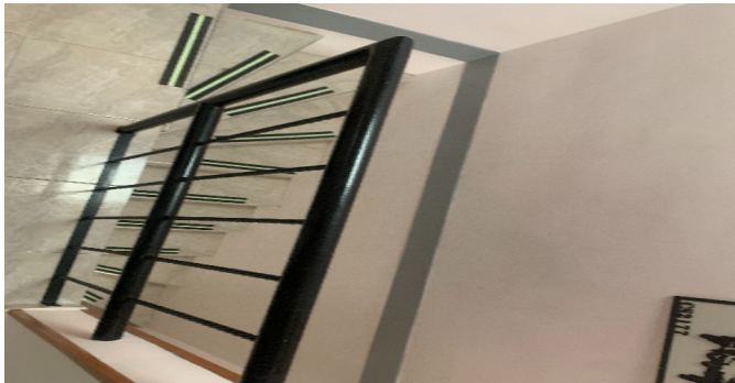
Escalera del inmueble
