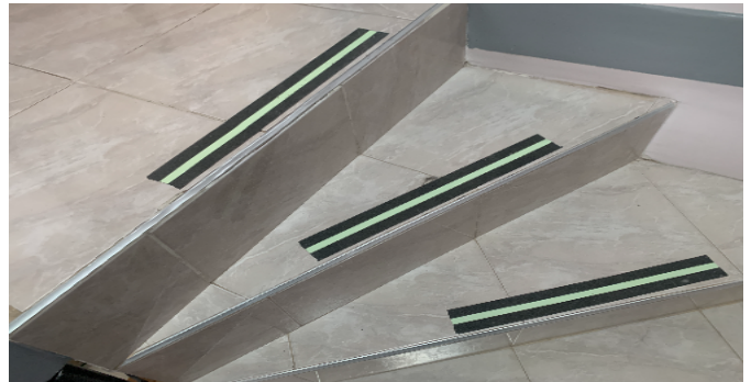
Escalera del inmueble
