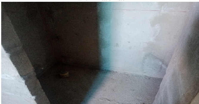
Baño Privado Hab 1
