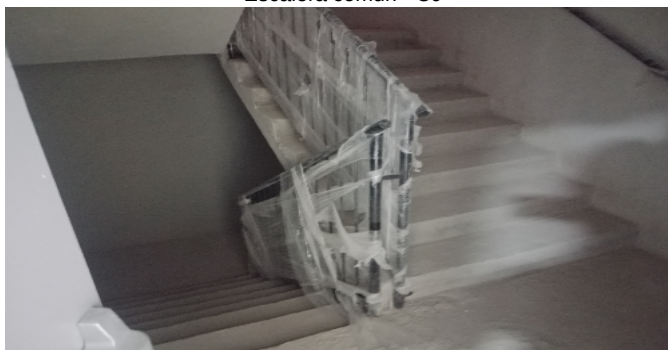
Escalera común - CJ
