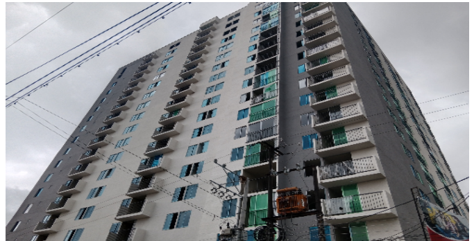
Fachada del Inmueble
