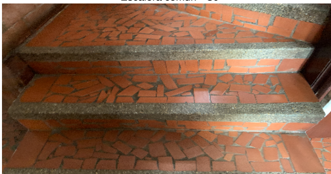
Escalera común - CJ
