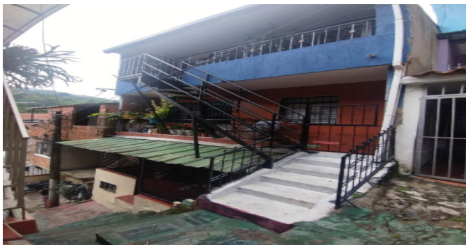
Fachada del Inmueble
