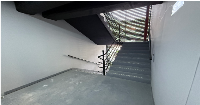
Escalera común - CJ
