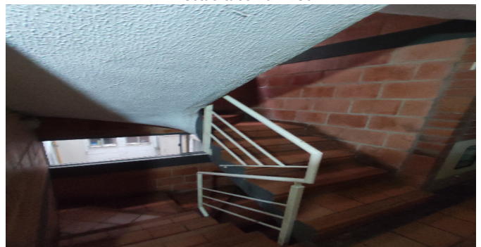
Escalera común - CJ
