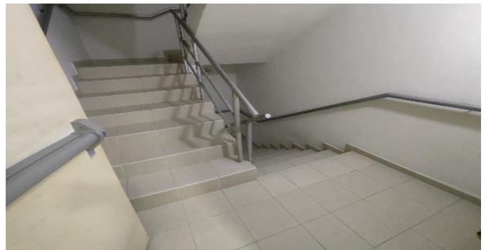
Escalera común - CJ
