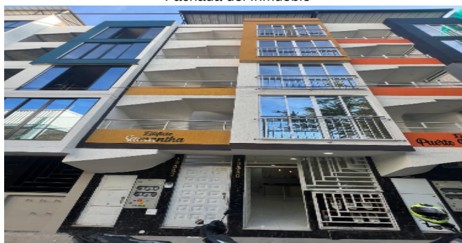
Fachada del Inmueble
