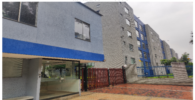
Fachada del Inmueble
