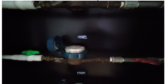
Contador de Agua
