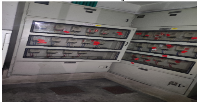
Contador de Energia
