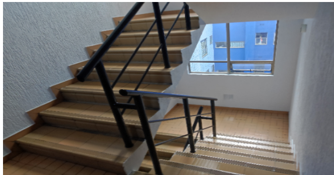
Escalera común - CJ
