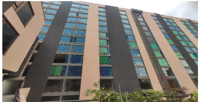
Fachada del Inmueble
