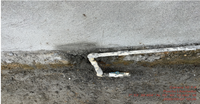
Acometida para contador de agua
