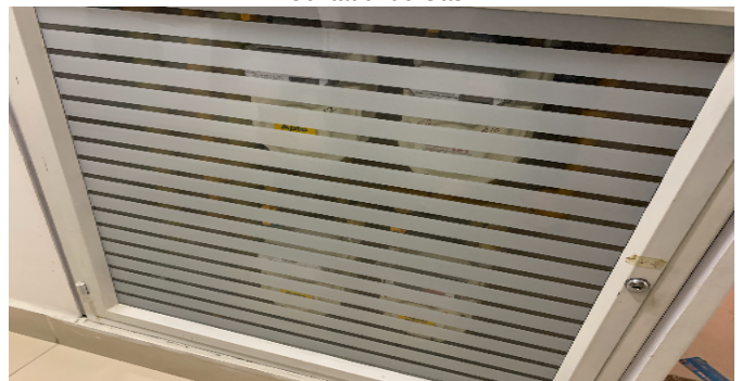
Contador de Gas
