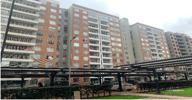
Fachada del Inmueble
