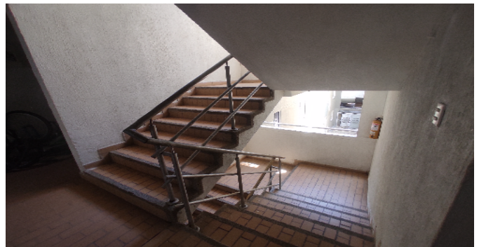
Escalera común - CJ
