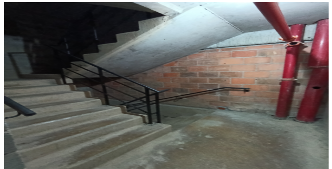
Escalera común - CJ
