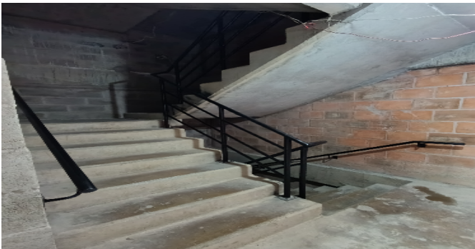
Escalera común - CJ
