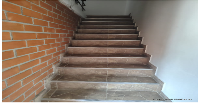
Escalera del inmueble
