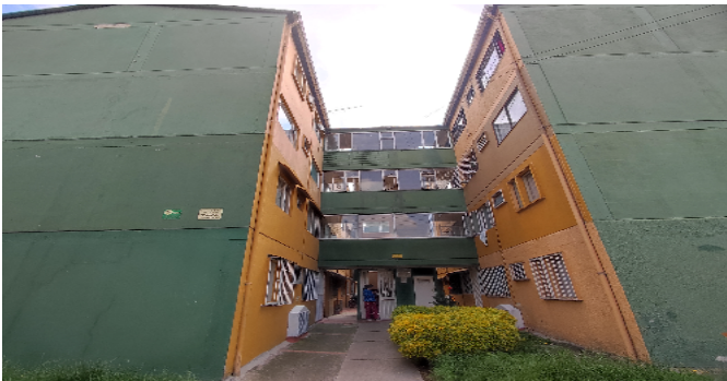
Fachada del Inmueble
