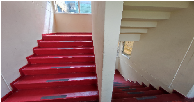
Escalera común - CJ
