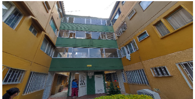
Fachada del Inmueble
