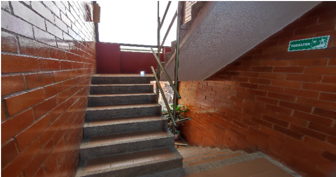
Escalera del inmueble
