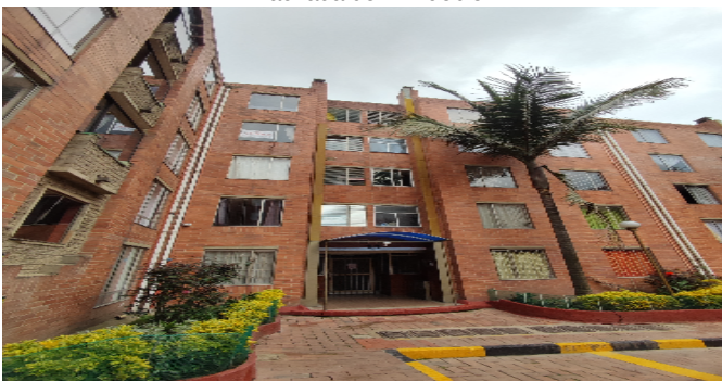
Fachada del Inmueble
