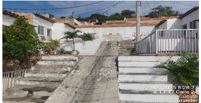
Escalera común - CJ
