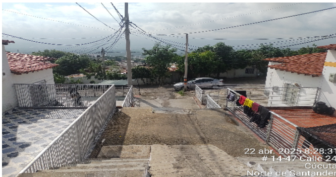
Escalera común - CJ
