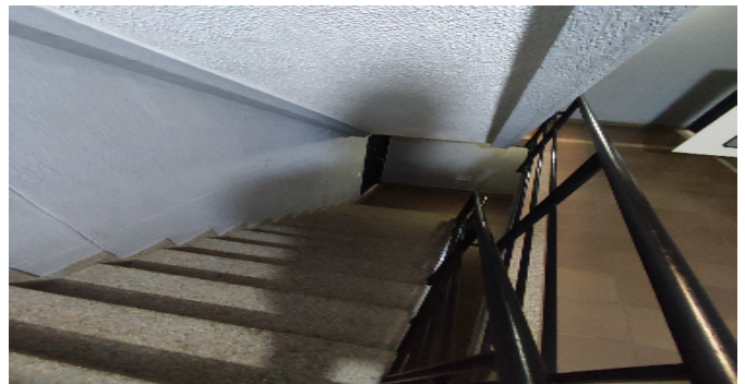
Escalera común - CJ
