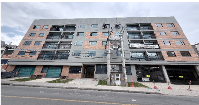
Fachada del Inmueble
