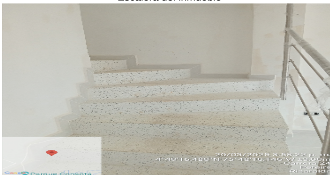
Escalera del inmueble
