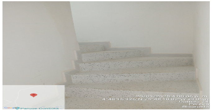
Escalera del inmueble
