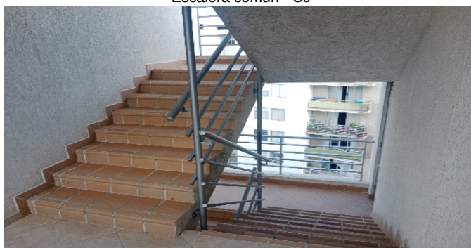
Escalera común - CJ
