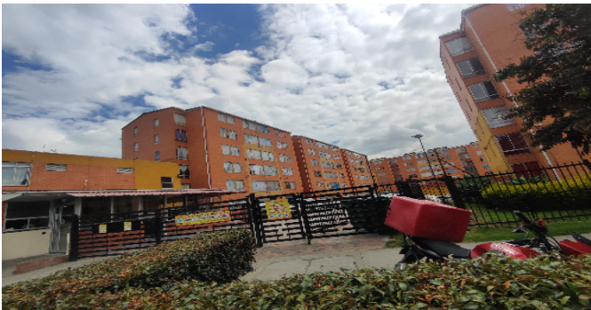
Fachada del Inmueble
