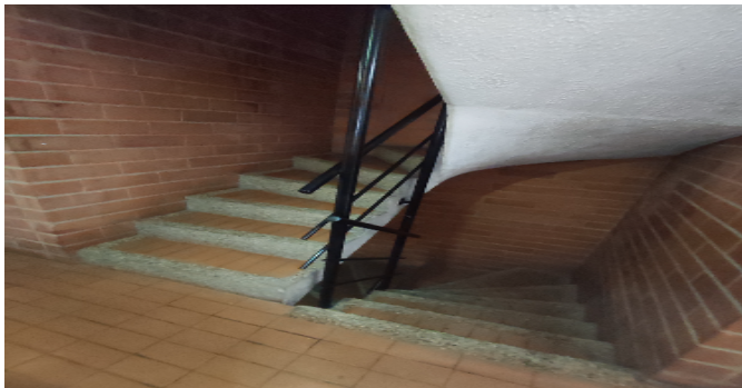
Escalera común - CJ
