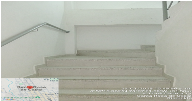
Escalera común - Cj
