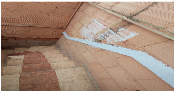
Escalera del inmueble
