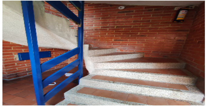
Escalera común - CJ
