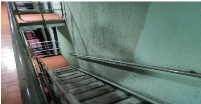
Escalera común - CJ
