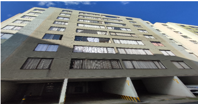
Fachada del Inmueble
