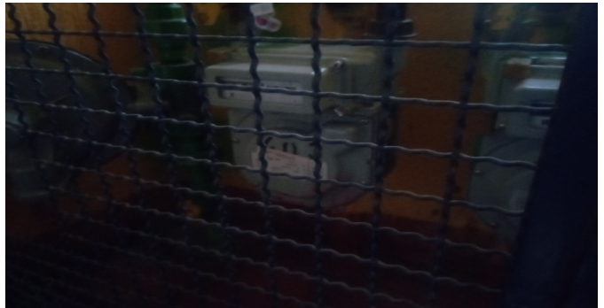
Contador de Gas
