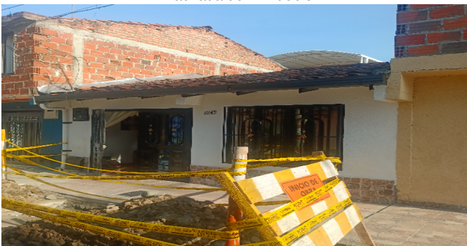
Fachada del Inmueble
