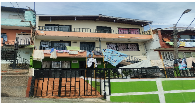
Fachada del Inmueble
