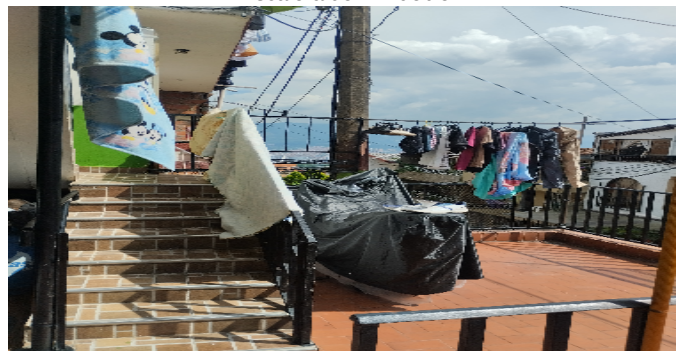
Escalera del inmueble
