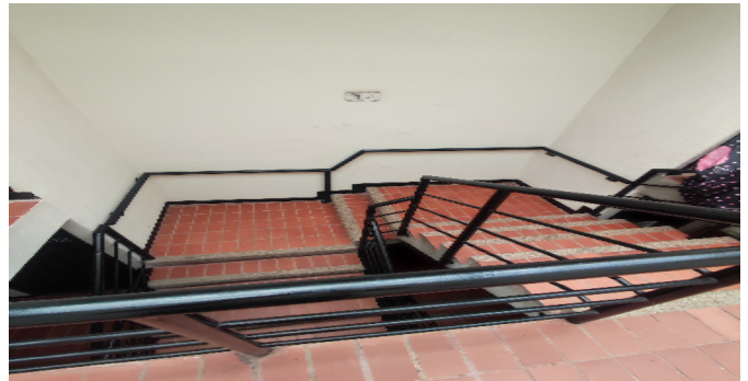
Escalera común - CJ
