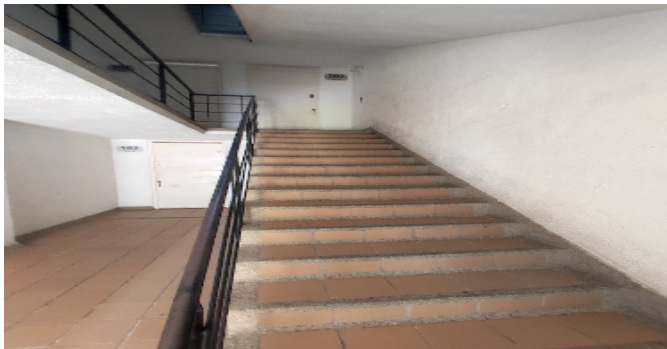
Escalera común - CJ
