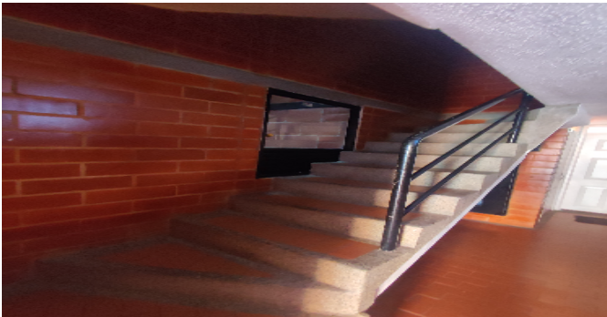
Escalera común - CJ
