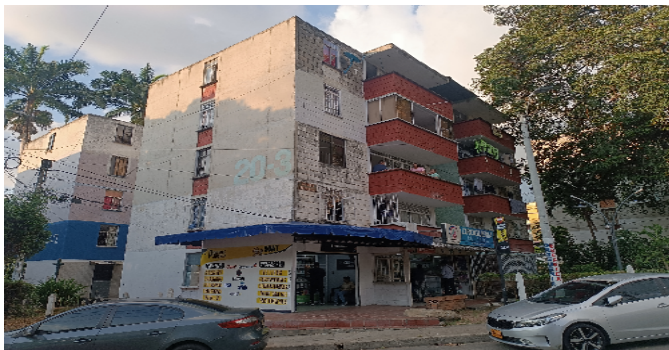
Fachada del Inmueble
