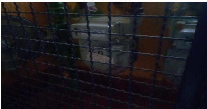
Contador de Gas
