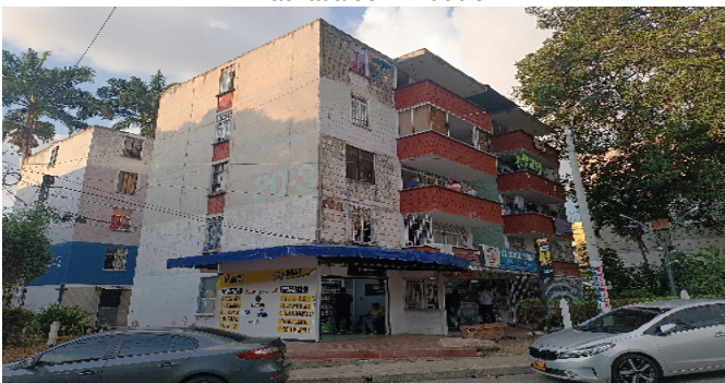
Fachada del Inmueble
