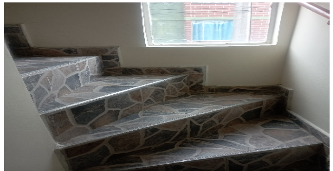
Escalera del inmueble
