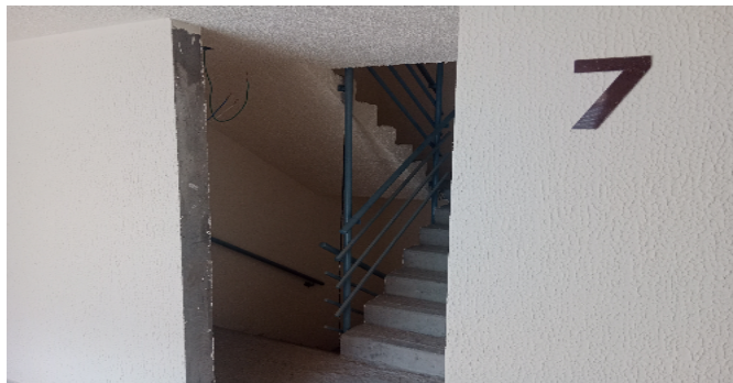
Escalera común - CJ
