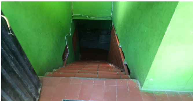
Escalera común - CJ
