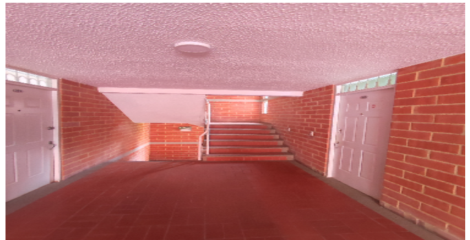
Escalera común - CJ
