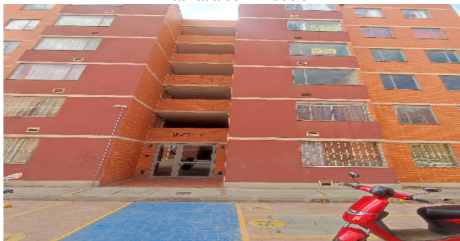
Fachada del Inmueble
