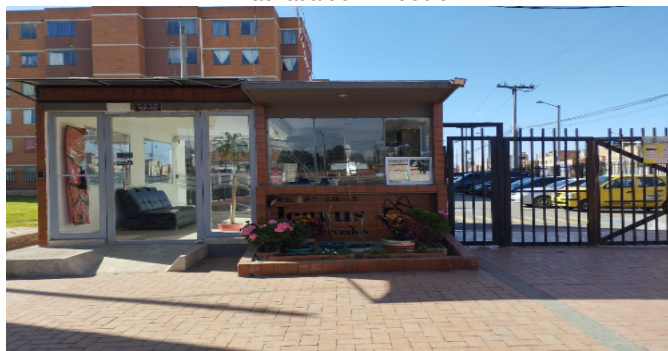
Fachada del Inmueble
